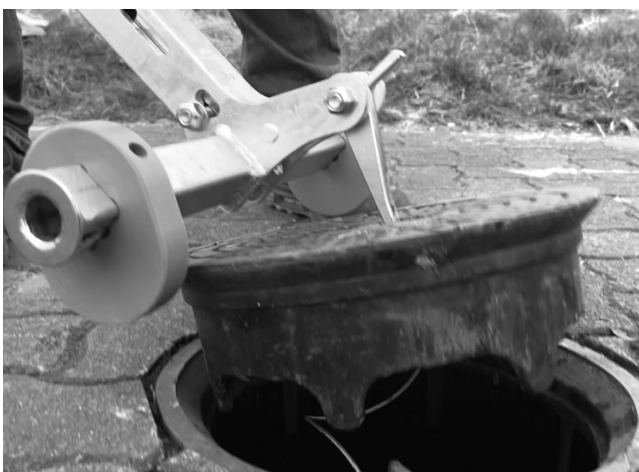
5. ... ausgehoben und zur Seite geschwenkt werden.
